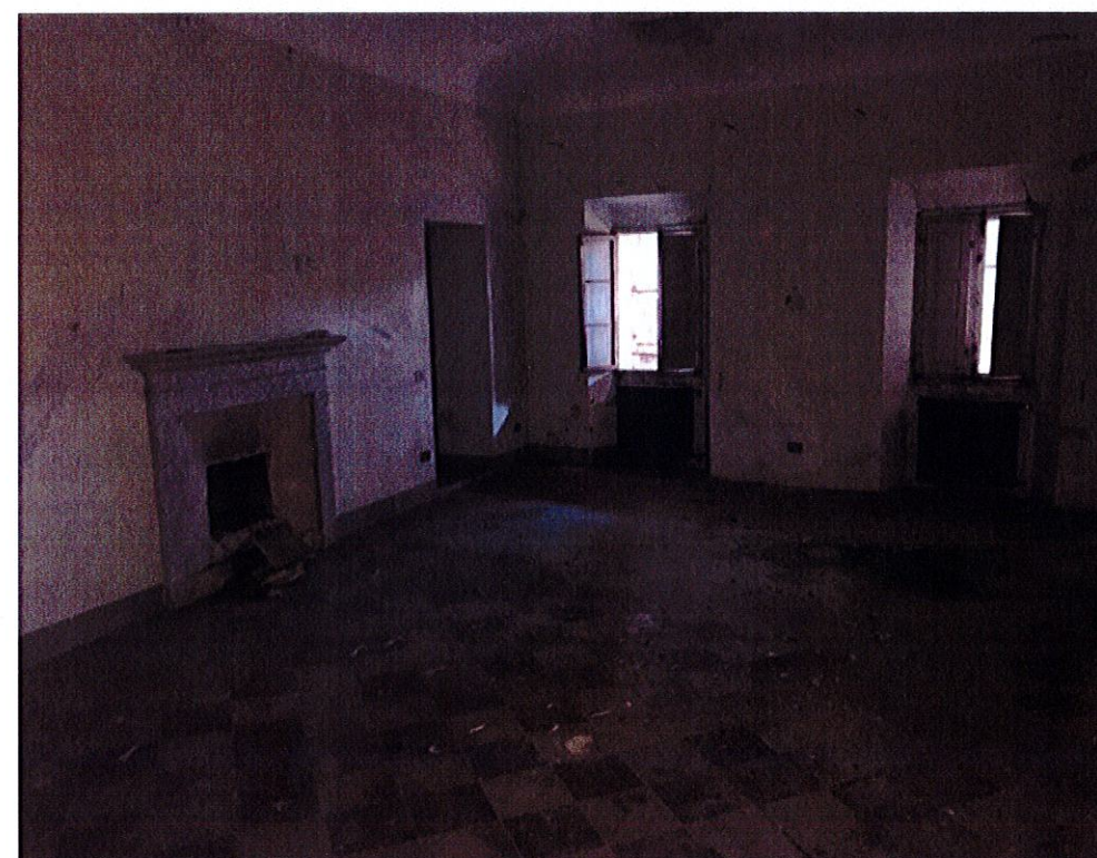
Vista Interna Villa Padronale
